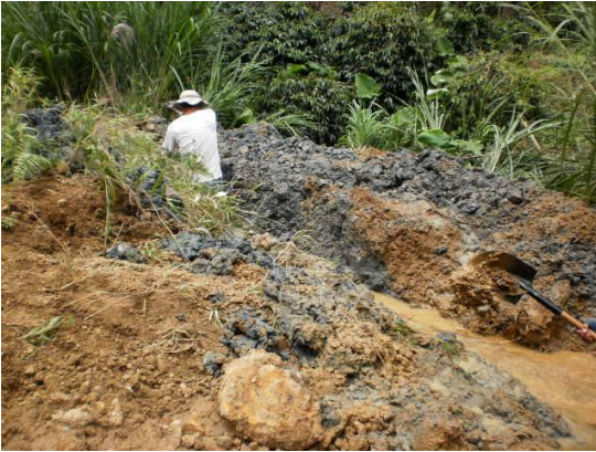
Fotografía 02 y 03. Limpieza deslizamiento.
