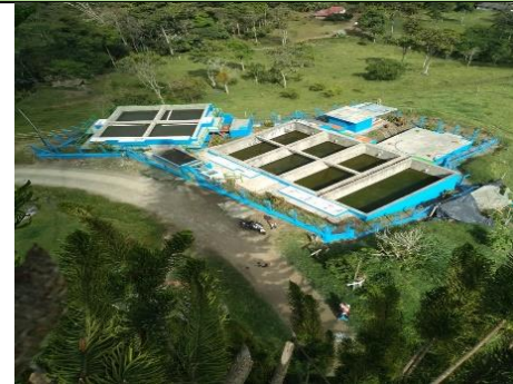
Foto N°2. Planta de tratamiento de agua potable ASUAACOVIR
