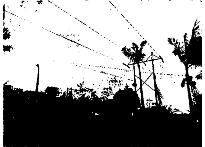
**Fotografía 7 y 8.** Interferencia de Palmas con las líneas de distribución de energía.
