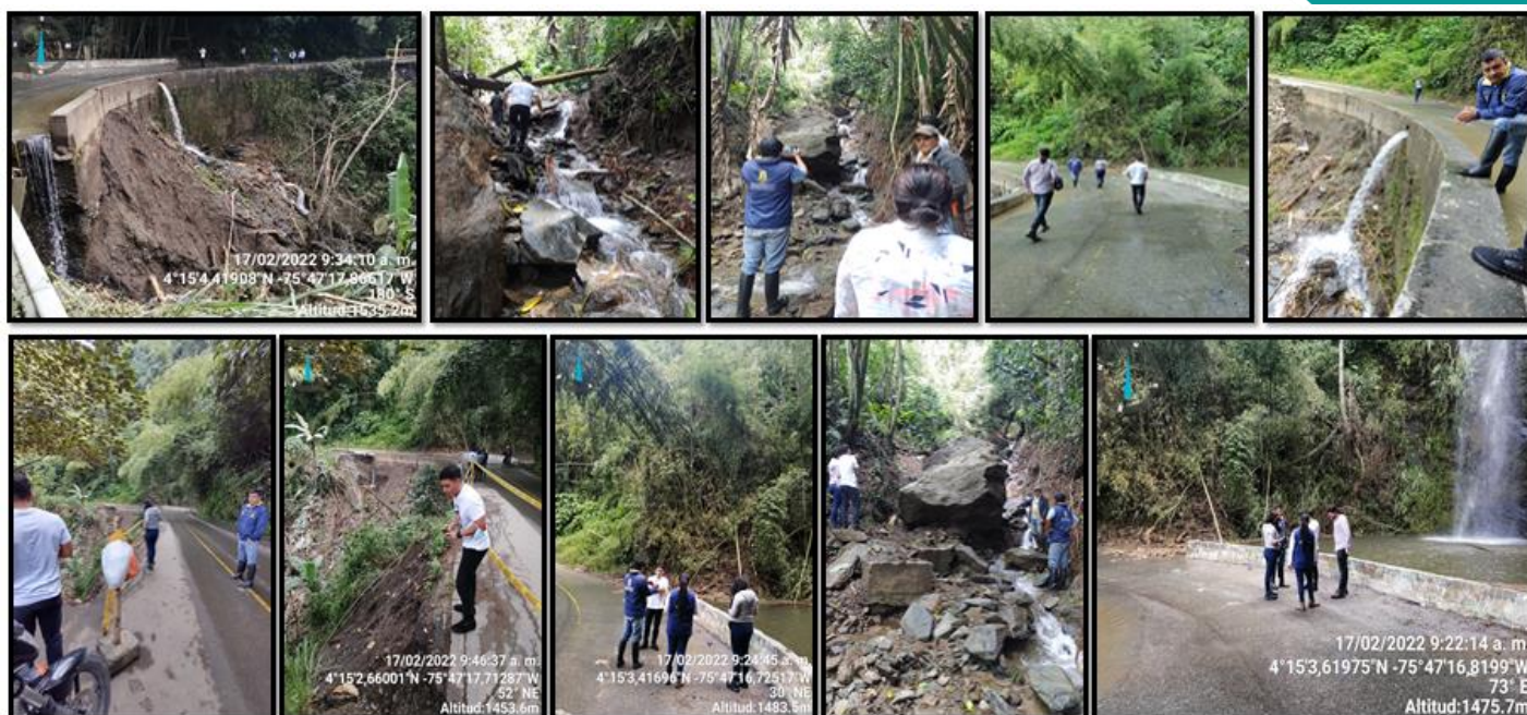
VISITA TECNICA EN EL SECTOR DE LAS BRISAS - MUNICIPIO DE GENOVA
