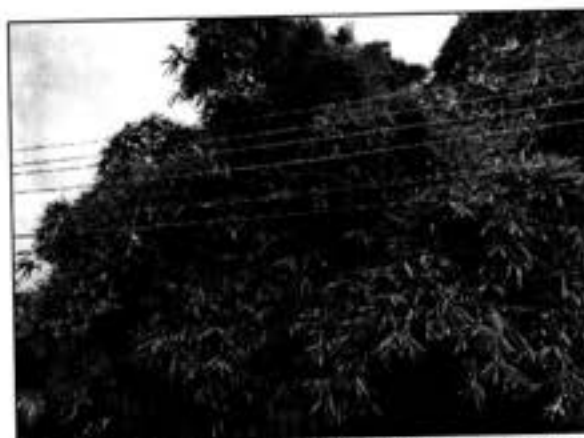
Fotografía 4. Registro fotográfico de como los culmos del bambusal comienzan a tocar el tendido eléctrico del condominio.
