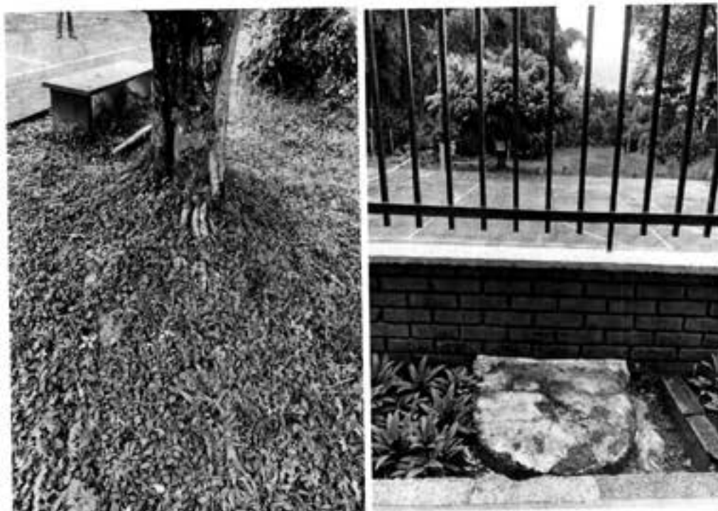
Registro fotográfico 5-6. Se observa el desprendimiento de partes aéreas del árbol de Eucalipto lo que ha ocasionado daños en parque infantil y cerramiento del conjunto.
