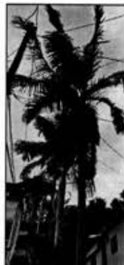
Fotografía 4. Observación de palmas reinas interfiriendo con las redes del alumbrado público.
