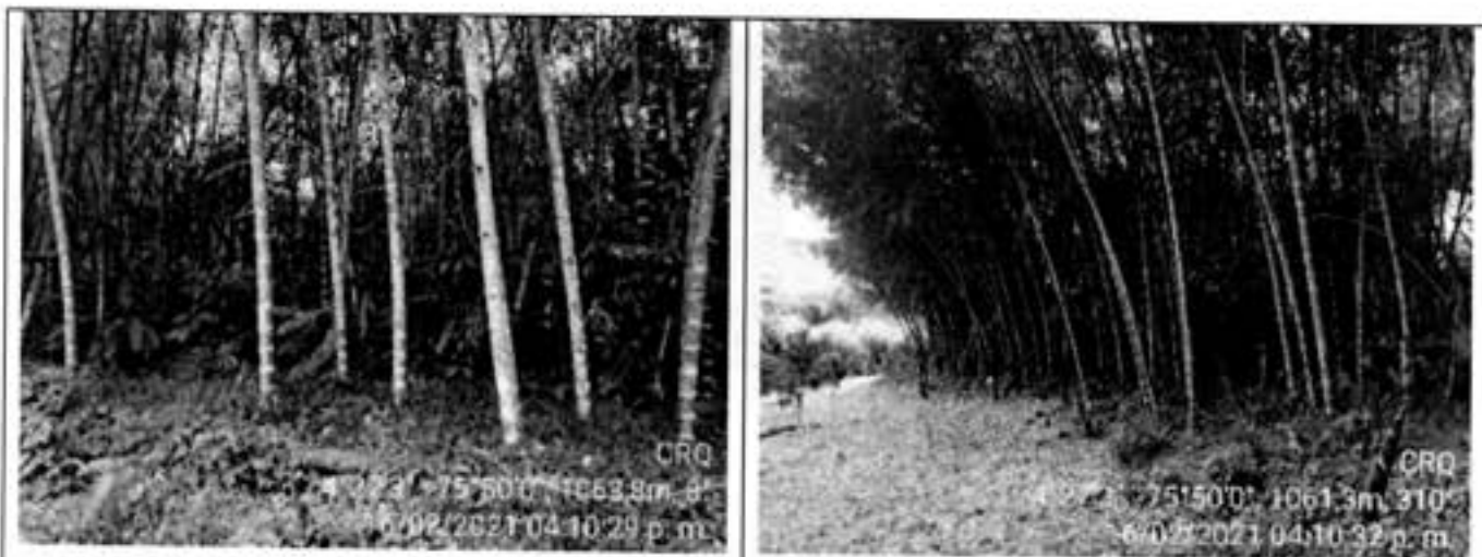
Fotografía No.1 y 2 Verificación de los puntos del levantamiento planimétrico y estado del guadua con necesidad de manejo.
