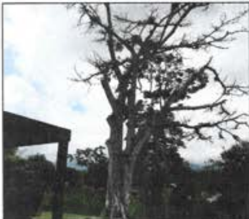
Fotografía 1. Árbol de Matapalo ubicado dentro del predio 12 del Conjunto Residencial Samarkanda; se puede observar su cercanía con la vivienda del predio.
