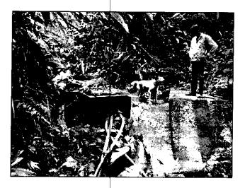
Fotografía 2. Tuberías de salida del sistema de captación
