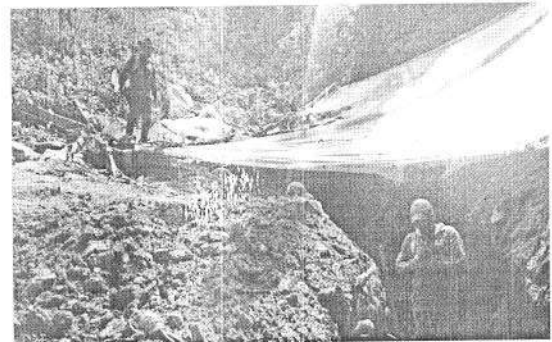
Figura 4. Excavación realizada. Fuente: Rendón N. // Municipio Calarcá 07/02/2018
