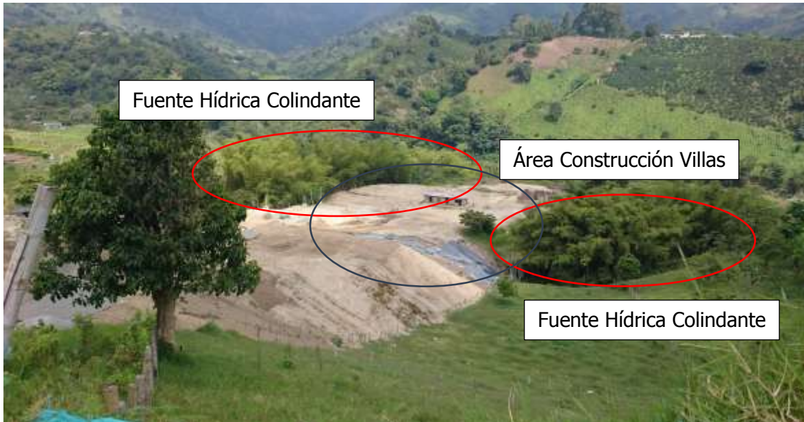
Imagen N° 2. Adecuación del terreno para la construcción de las Villas.
