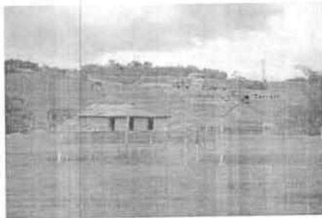
Figura 2. Panorámica de la intervención en el proyecto "Natural Club Parque Residencial". La parte en ladera y la parte plana inferior para posibles casas y villas.
