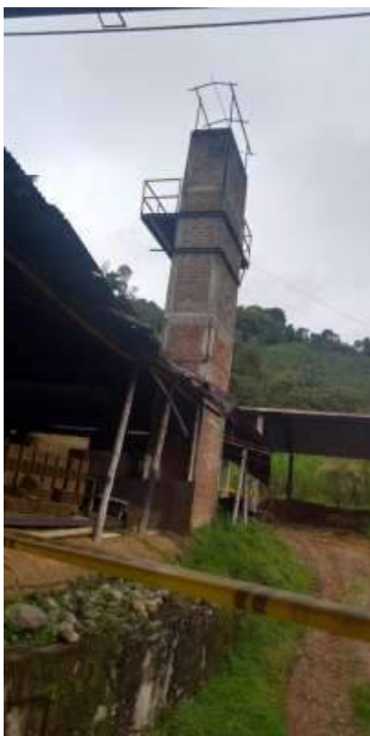
Foto 3. Chimenea con plataforma
