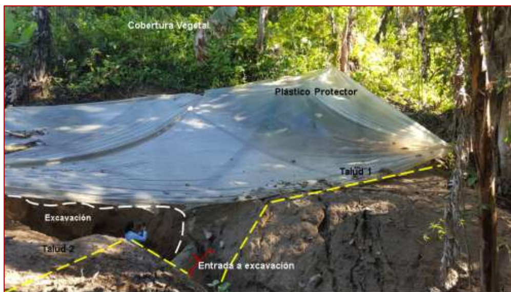
Figura 15. Configuración del sitio excavado. Fuente: Peña G. // SRCA-CRQ 07/02/2018
