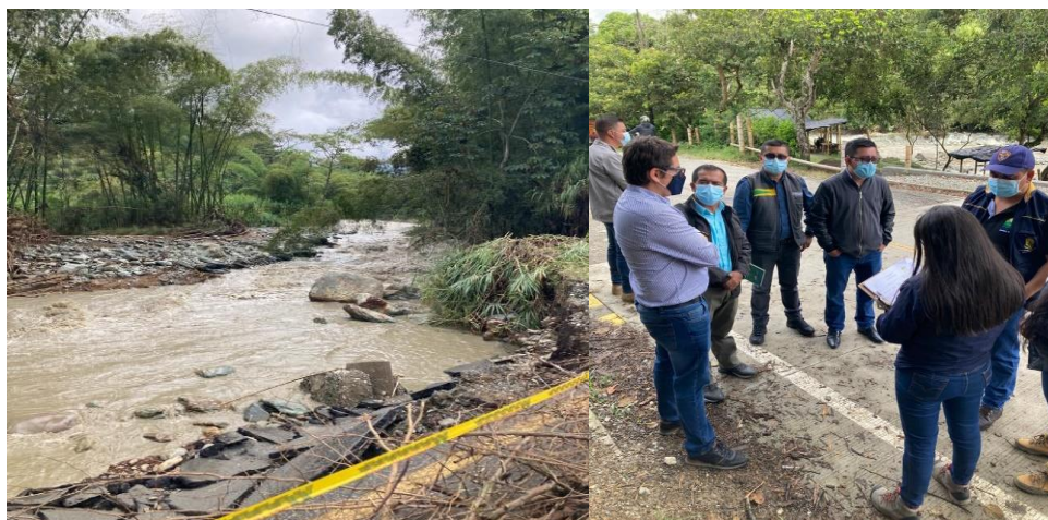
Visita técnica municipio de Córdoba afectación de río verde sobre la vía vehicular. 12 de marzo de 2021.
