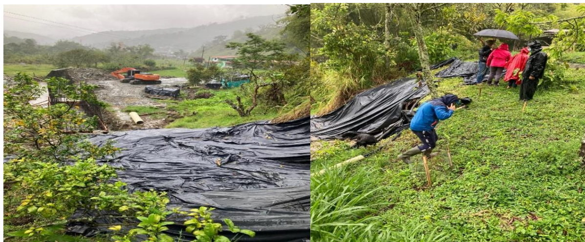
Visita técnica. Municipio de Pijao predio karibu, vereda Guamal-pizarras afectación deslizamiento, derecho de petición # .2394, 2491 y 2493, 15 de marzo.
