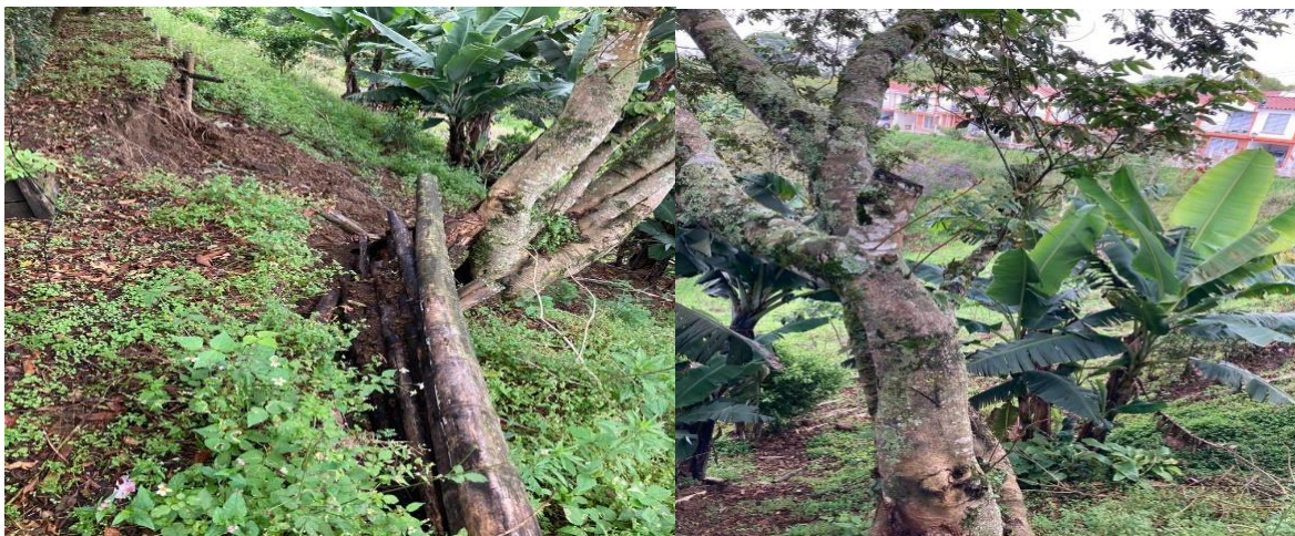
Visita técnica, municipio de circasia, condominio girasoles, derecho de petición # 2444. Deslizamiento en zona verde, 12 de marzo de 2021.
