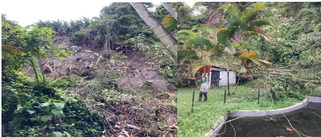
Visita técnica, municipio de Salento, vereda san juan de carolina, urbanización campestre luna del rio, deslizamiento, derecho de petición # 2635, 15 de marzo de 2021.
