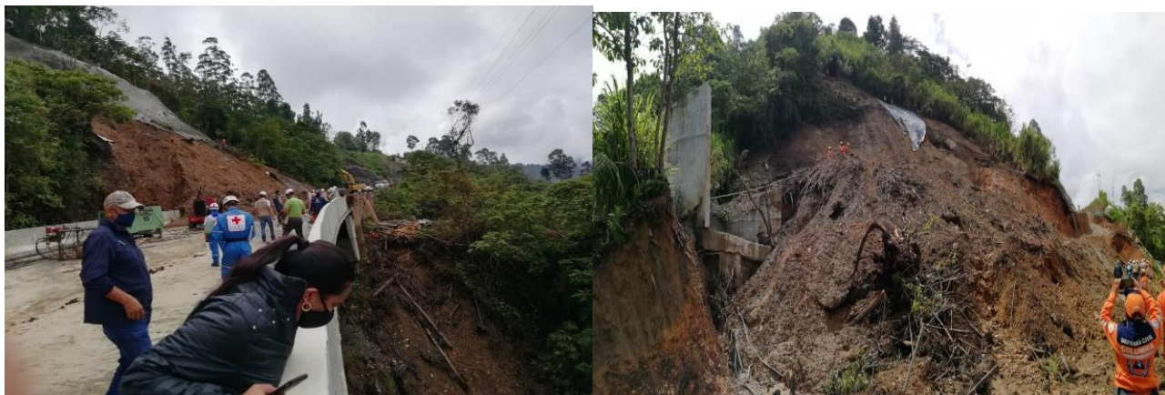
Visita técnica, municipio de Calarcá, recorrido sector alto de la línea. Deslizamientos en la vía. 4 de marzo 2021.
