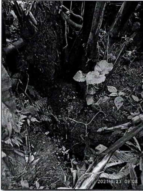
Figura 4. Sector con afloramiento de agua
