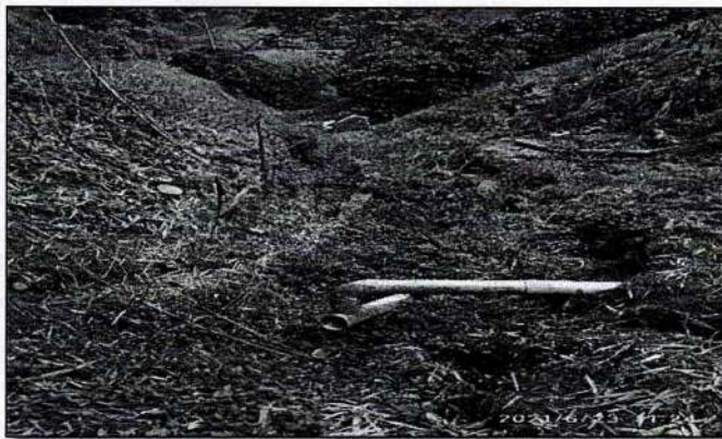
Figura 21. Estructura (Box Culvert).
