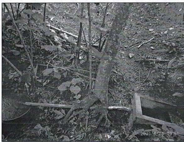
Figura 10. Estructura de recolección de aguas
