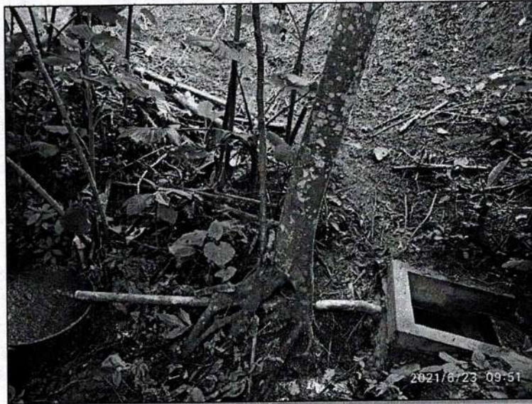
Figura 10. Estructura de recolección de aguas
