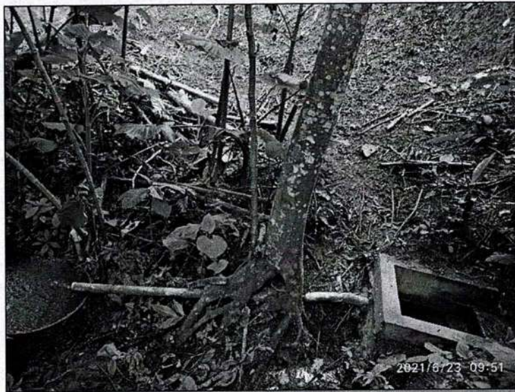
Figura 10. Estructura de recolección de aguas
