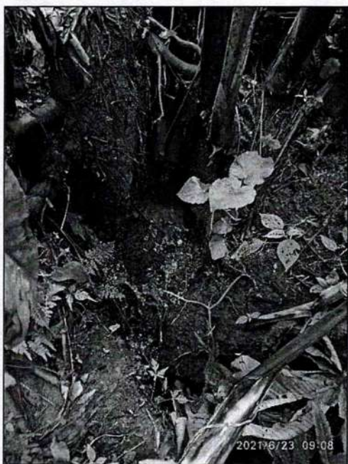
Figura 4. Sector con afloramiento de agua
