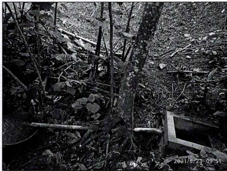
Figura 10. Estructura de recolección de aguas
