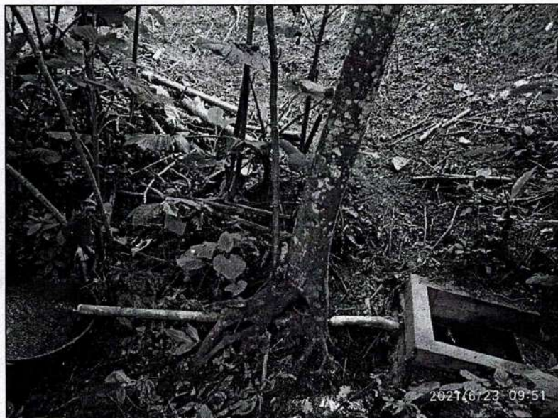
Figura 10. Estructura de recolección de aguas
