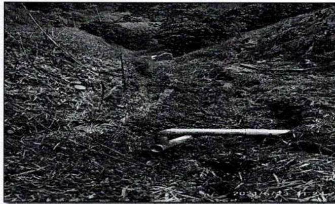
Figura 21. Estructura (Box Culvert)
