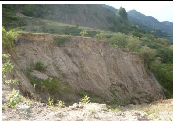
Deslizamiento en masa, cárcava predio El Placer. Registro fotográfico 2013
