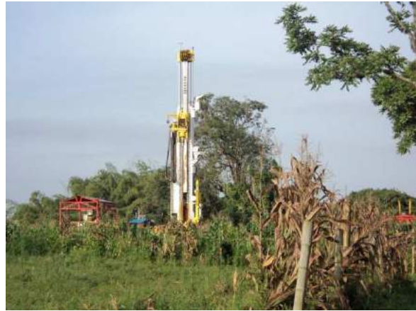
Construcción Pozo profundo – Montenegro
