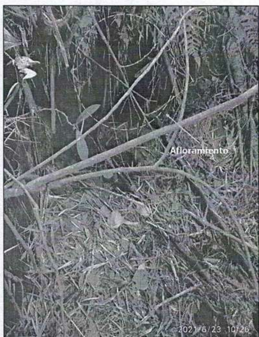
Figura 12. Afloramiento con presencia de agua
