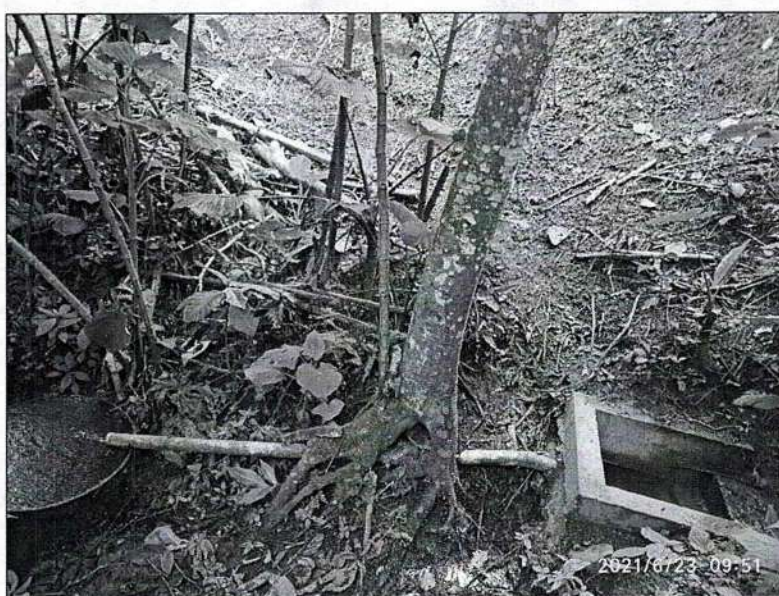
Figura 10. Estructura de recolección de aguas
