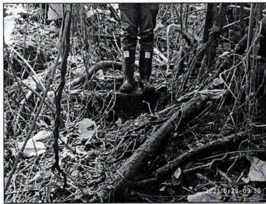
Figura 7. Estructura en concreto
