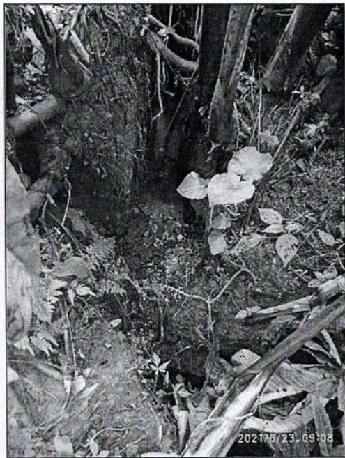
Figura 4. Sector con afloramiento de agua
