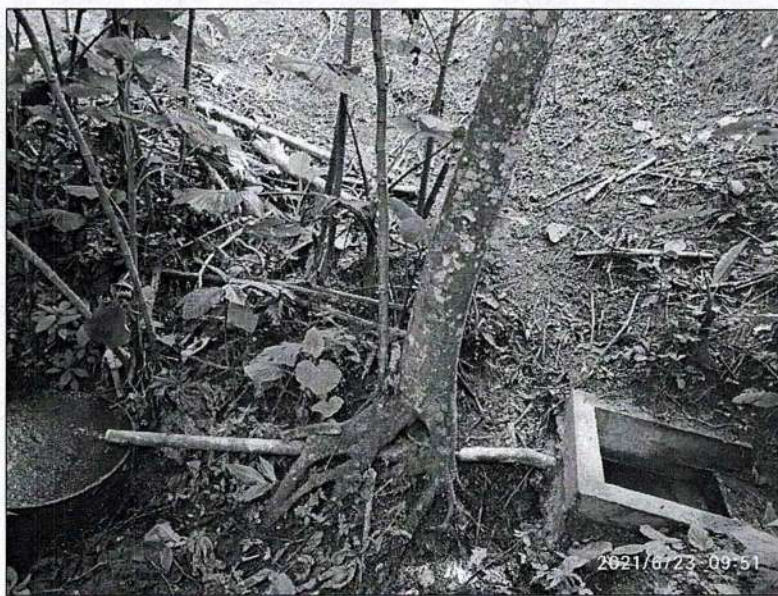
Figura 10. Estructura de recolección de aguas
