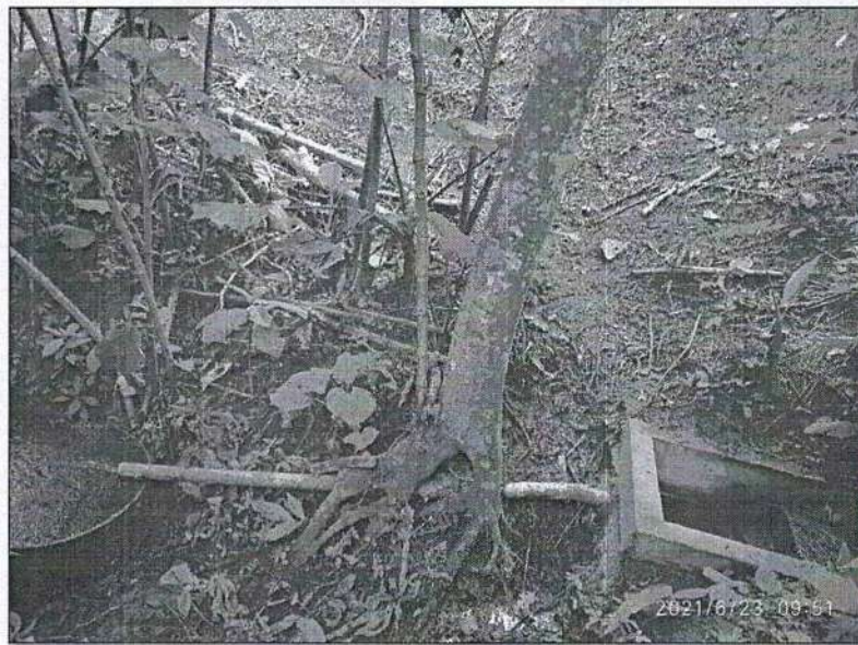
Figura 10. Estructura de recolección de aguas
