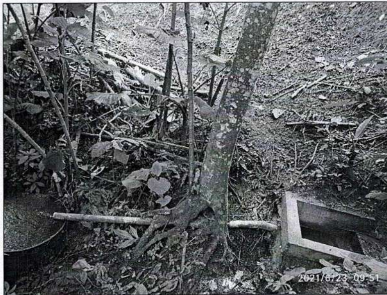
Figura 10. Estructura de recolección de aguas
