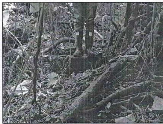
Figura 7. Estructura en concreto
