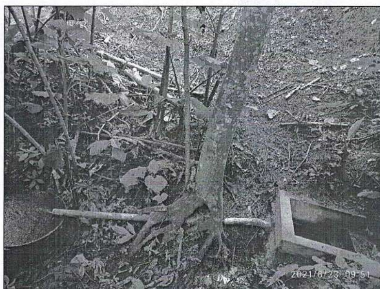
Figura 10. Estructura de recolección de aguas
