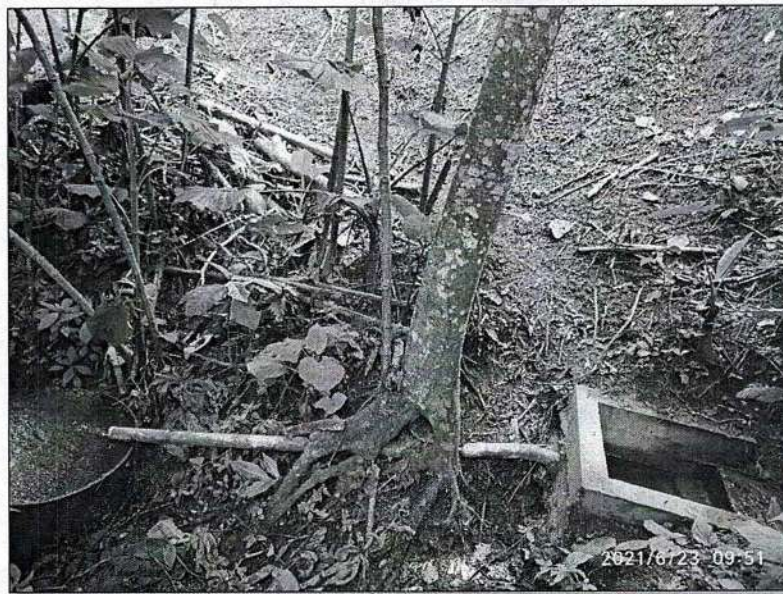
Figura 10. Estructura de recolección de aguas
