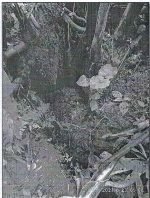
Figura 4. Sector con afloramiento de agua
