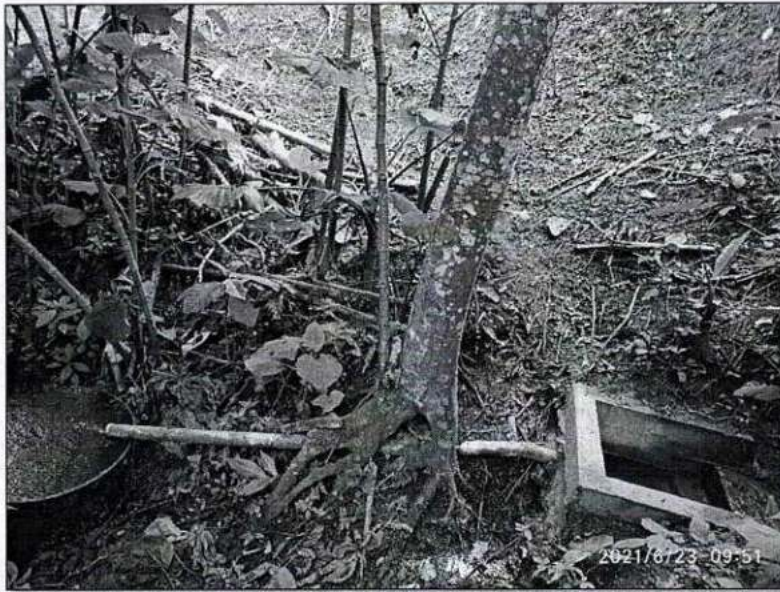
Figura 10. Estructura de recolección de aguas
