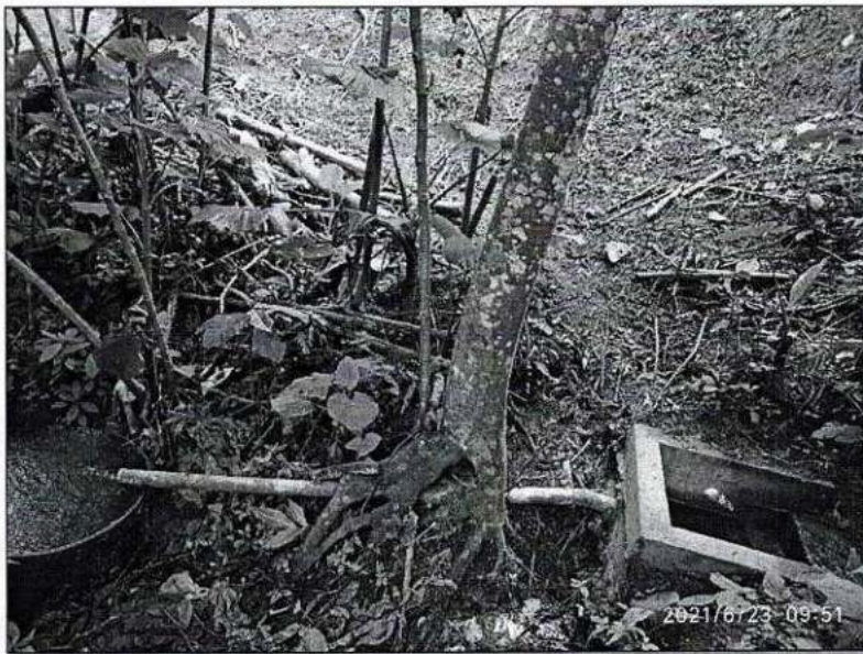
Figura 10. Estructura de recolección de aguas
