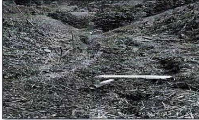
Figura 21. Estructura (Box Culvert)
