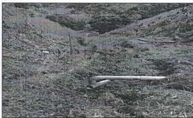
Figura 21. Estructura (Box Culvert)
