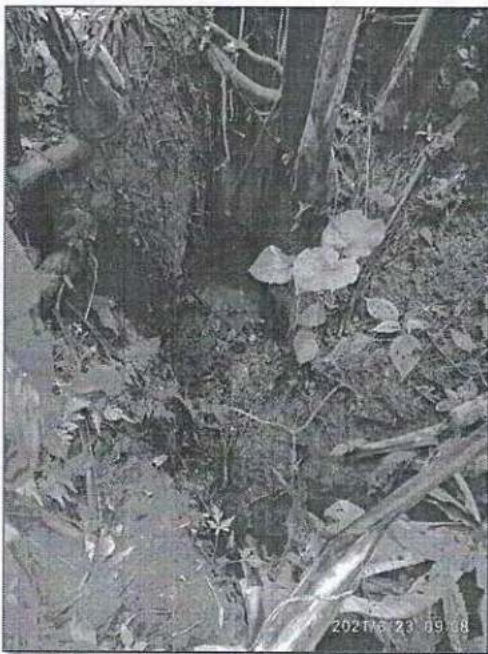
Figura 4. Sector con afloramiento de agua
