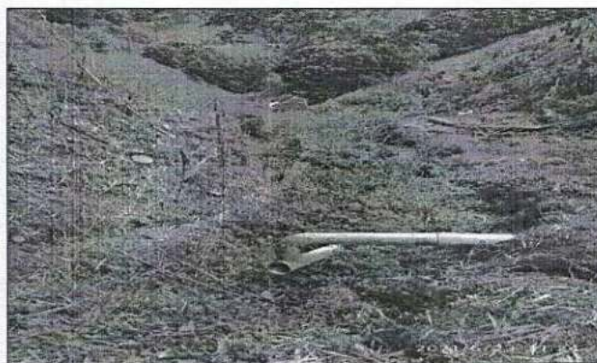
Figura 21. Estructura (Box Culvert)
