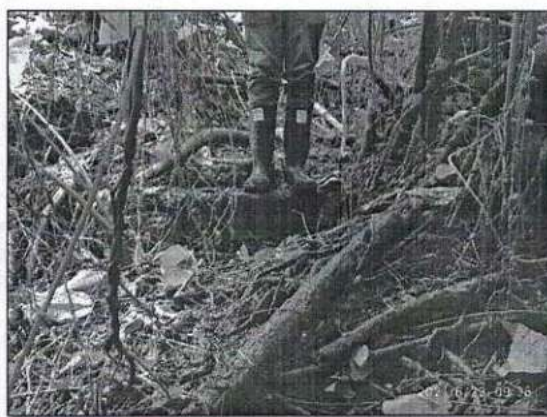
Figura 7. Estructura en concreto
