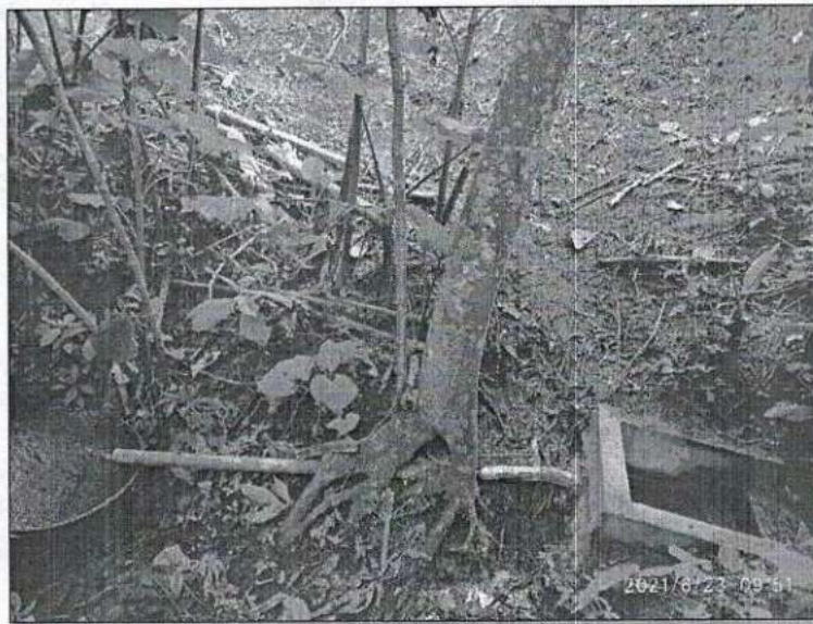
Figura 10. Estructura de recolección de aguas
