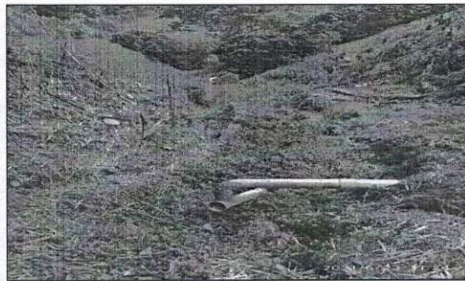
Figura 21. Estructura (Box Culvert)
