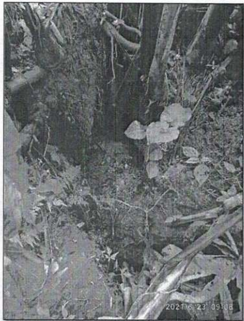
Figura 4. Sector con afloramiento de agua
