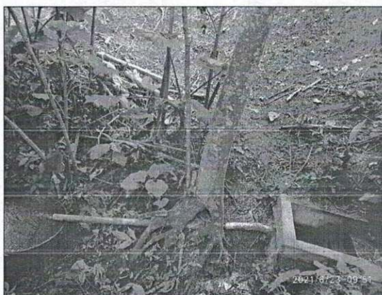
Figura 10. Estructura de recolección de aguas
