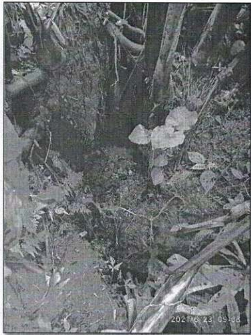
Figura 4. Sector con afloramiento de agua
