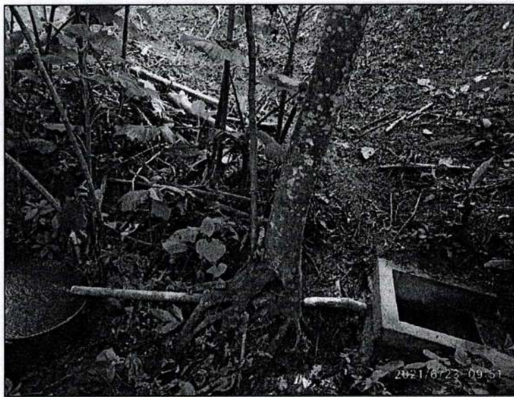
Figura 10. Estructura de recolección de aguas
