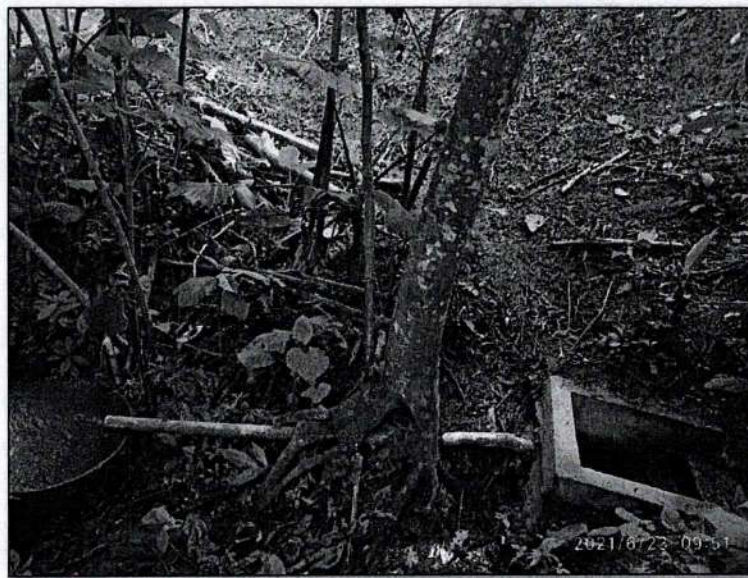
Figura 10. Estructura de recolección de aguas
