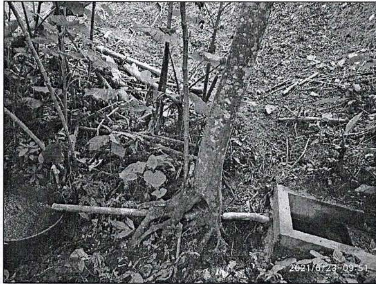
Figura 10. Estructura de recolección de aguas
