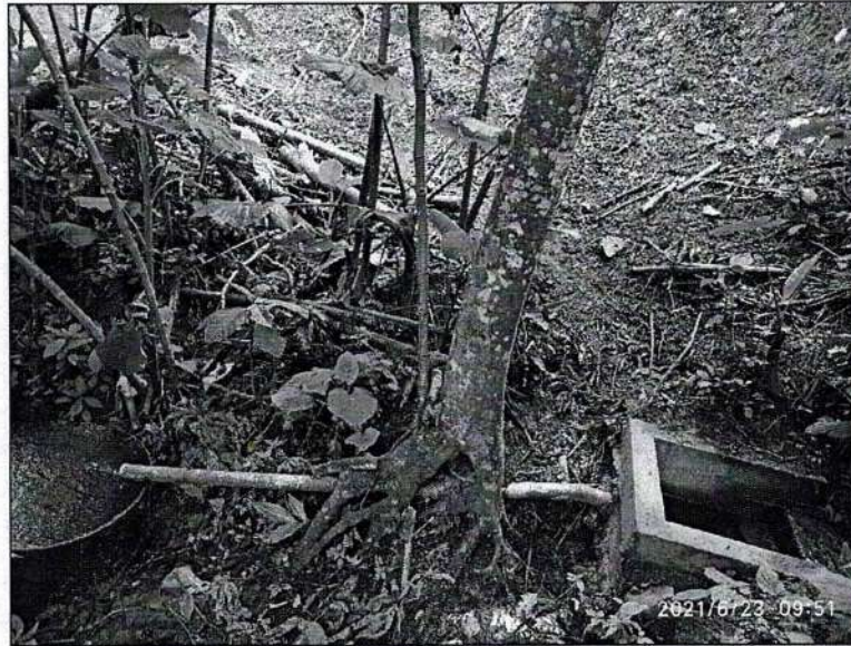
Figura 10. Estructura de recolección de aguas
