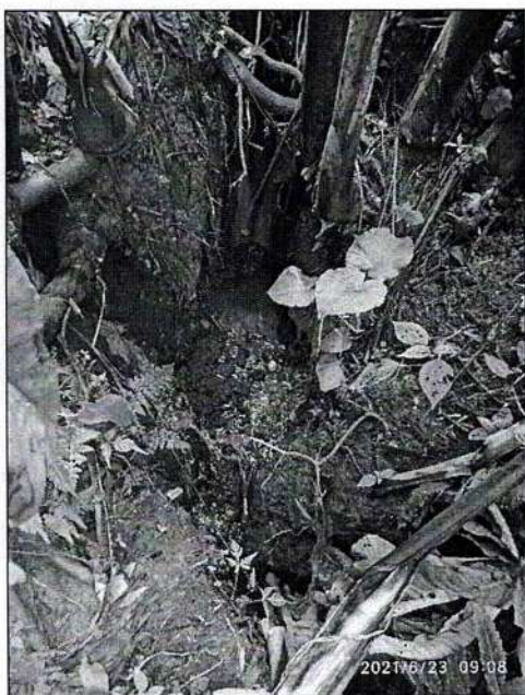
Figura 4. Sector con afloramiento de agua
