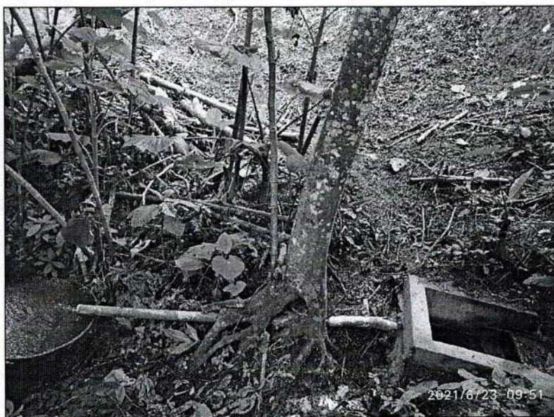
Figura 10. Estructura de recolección de aguas
