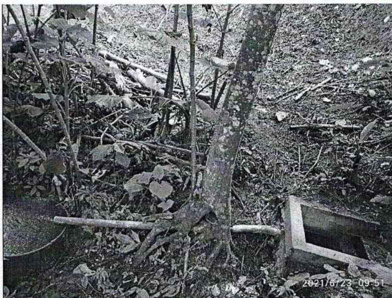
Figura 10. Estructura de recolección de aguas
