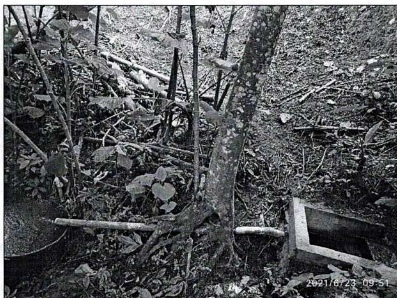
Figura 10. Estructura de recolección de aguas
