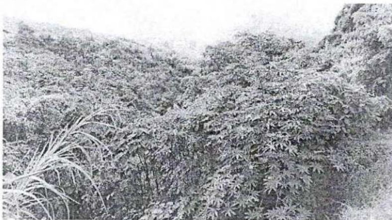
Fotografía 2. Sitio de construcción de box culvert
