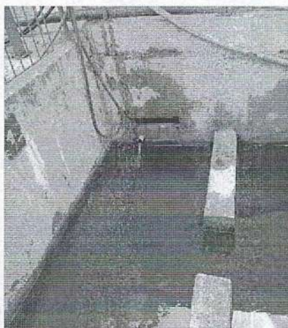
Fotografía 1. Captación del sistema
