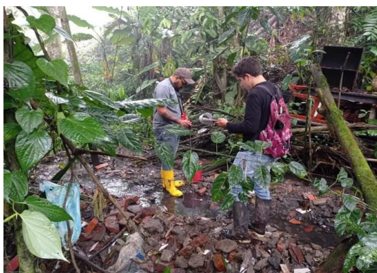
Limpieza de Quebradas
