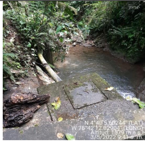
Fotografía N°8. Bocatoma Pativilca, Filandia. Acueducto Maravelez-Alcalá
