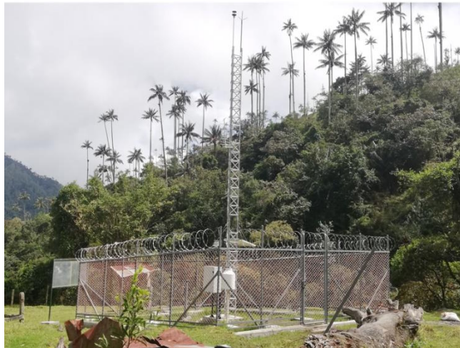
Vista general de la infraestructura de la estación meteorológica El Ocaso, municipio de Salento.
