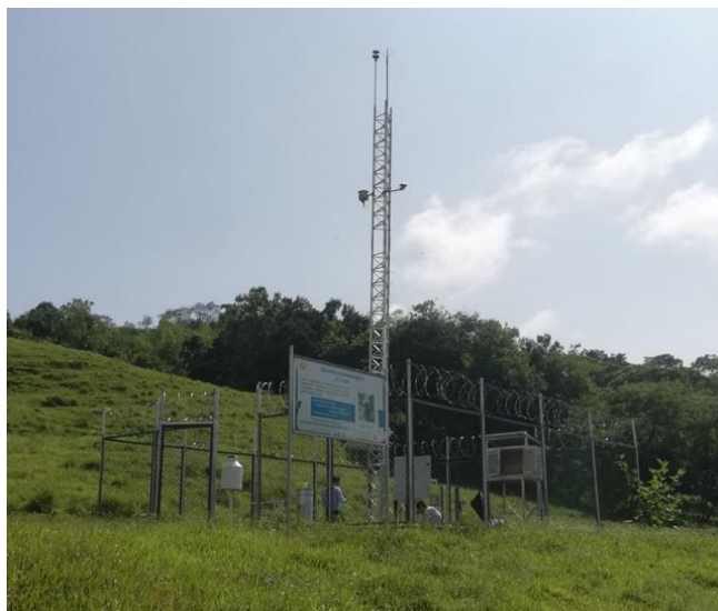
Vista general de la infraestructura de la estación meteorológica El Ocaso, municipio de Quimbaya.
