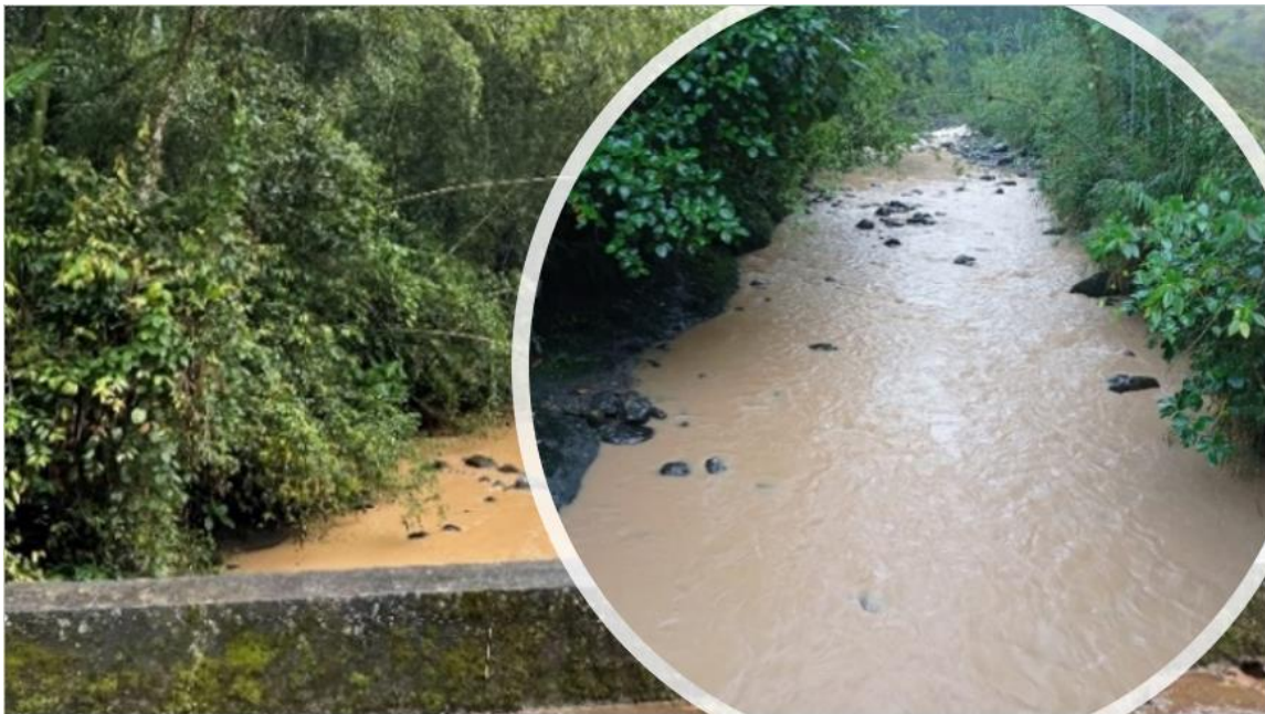
Figura 40. Registro fotográfico puente La Balastrea sobre río Barbas.
