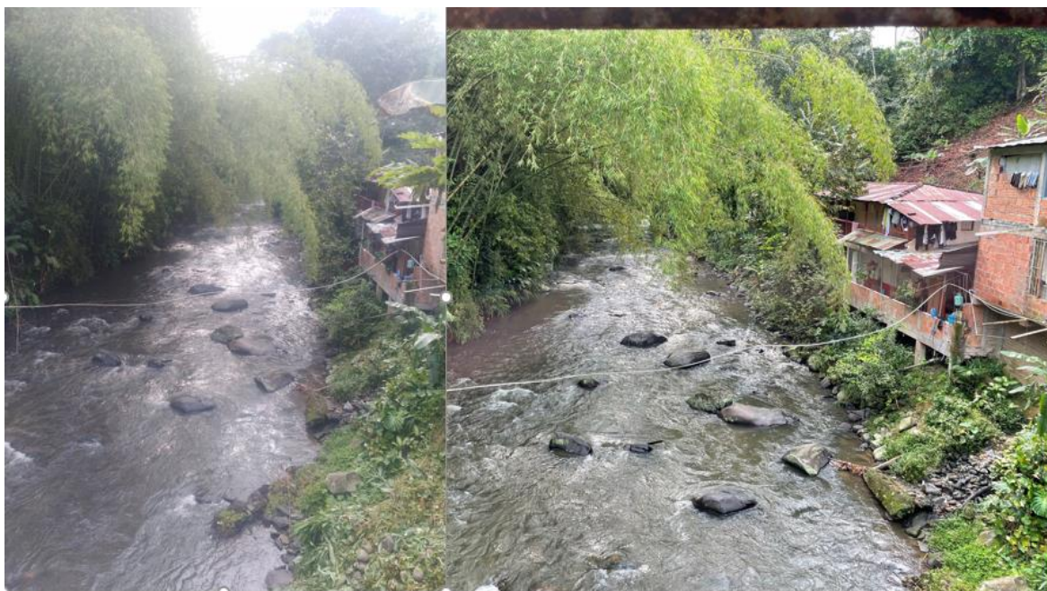
Figura 43. Registro fotográfico puente vía Pereira-Alcalá sobre río Barbas.
