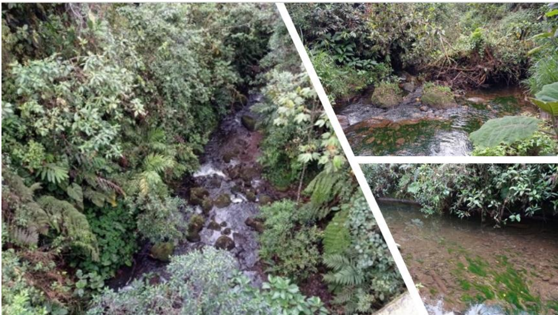
Figura 39. Registro fotográfico puente El Manzano sobre río Barbas.
