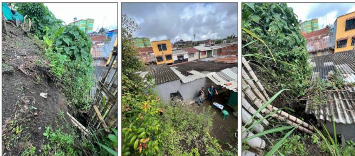
VISITA TECNICA BARRIO LA MILAGROSA - MANZANA 7 - ARMENIA.
