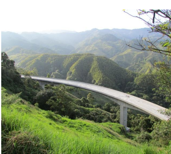
Figura 3a. Puente vía Calarcá-Cajamarca, sector la línea. (Foto: D. Fonseca, 2013)
