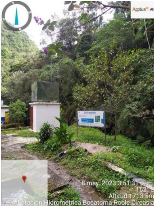
Ilustración 1. Estado inicial de la estación.
