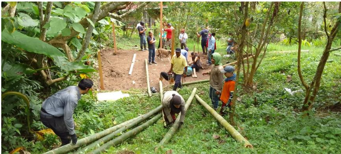
Taller construcción Biofábrica Ecoaldea Illary, Pijao.
