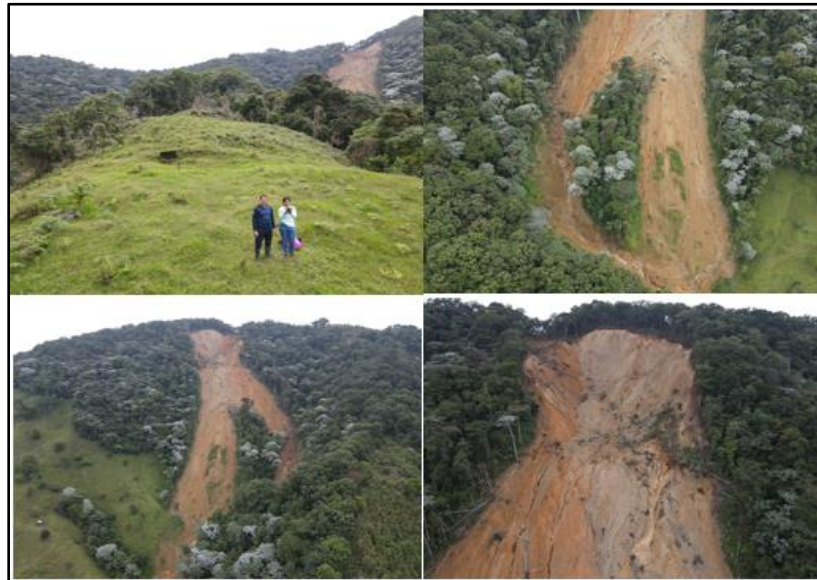
Imagen. Monitoreo deslizamiento predio el pensamiento – vereda Rio Gris – Génova – Marzo 23-2023
