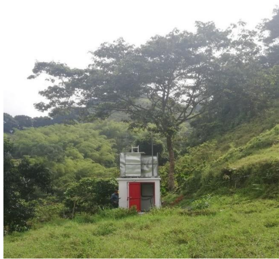
Vista general de la infraestructura de la estación hidrométrica Paso de los Aguadeños, municipio de Circasia.
