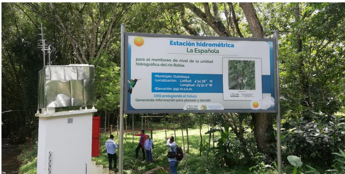
Vista general de la infraestructura de la estación hidrométrica La Española, municipio de Quimbaya.
