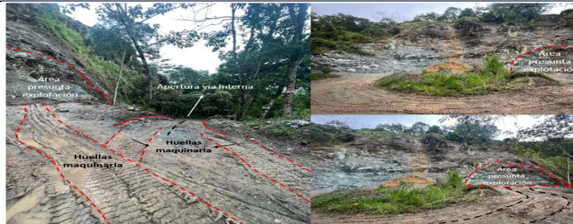
FOTOGRAFÍA 2. Estado Actual Cantera Serpentina Córdoba Licencia de Explotación No. 22528 (cuya vigencia expiró el 03/09/2016).
