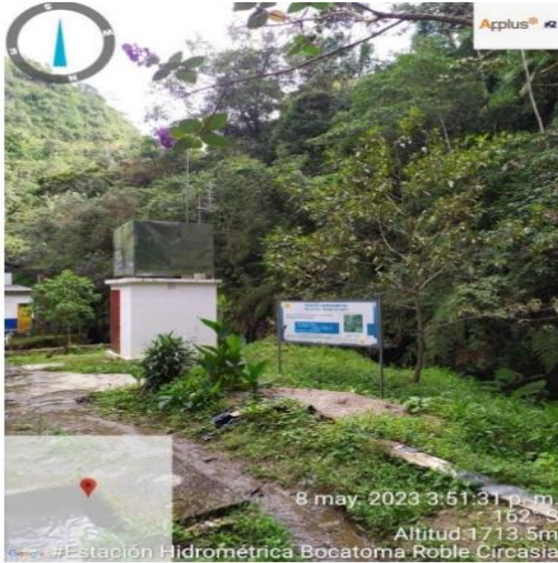
Ilustración 1. Estado inicial de la estación.
