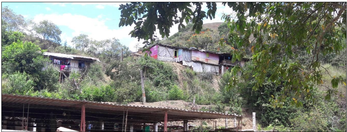
Fotografía 11 Deslizamiento activo presente en el Caserío La Estación Caicedonia del municipio de Sevilla.
