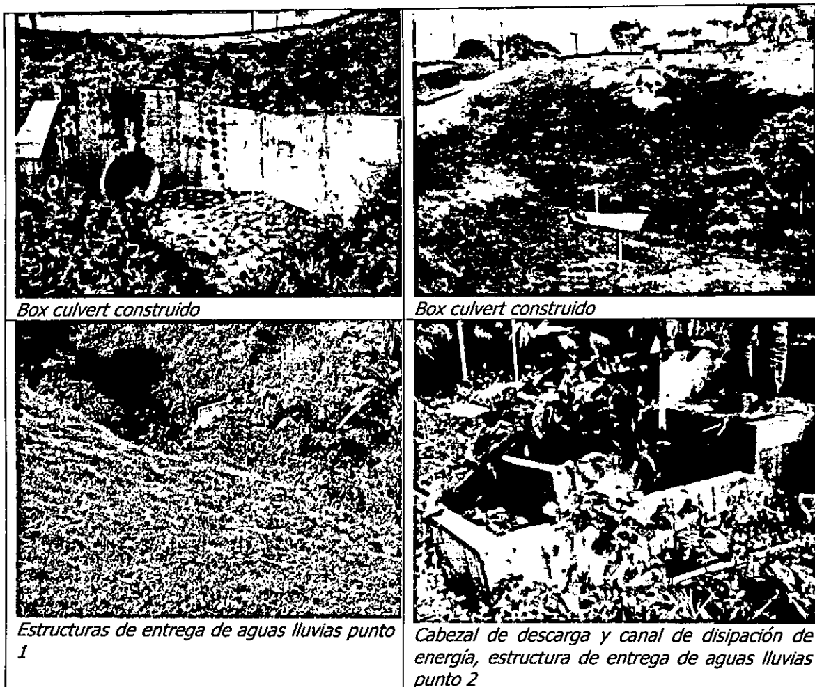
Figura 24. Ubicación obras construidas
