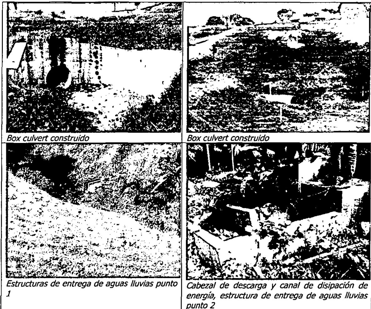
Figura 24. Ubicación obras construidas
