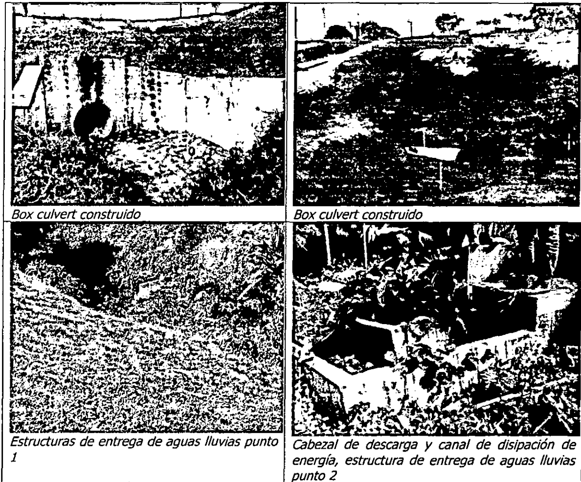
Figura 24. Ubicación obras construidas
