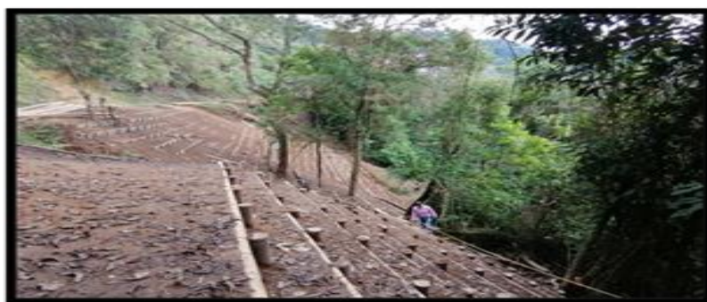
Construcción de trinchos Salento
