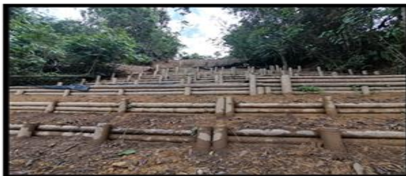
Construcción de trinchos
