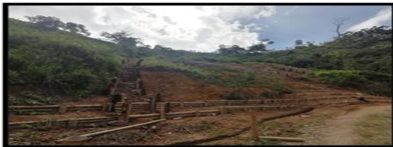
Construcción de trinchos
