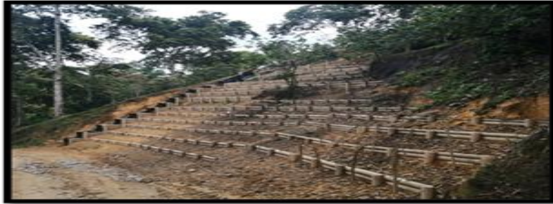
Construcción de trinchos, municipio de Córdoba
