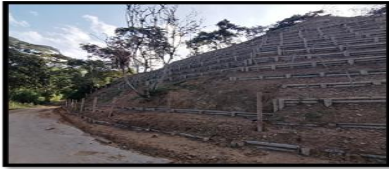
Construcción de trinchos Calarcá
