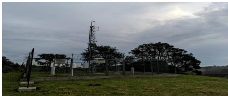
Vista general de la infraestructura de la estación meteorológica Bremen, municipio de Filandia
