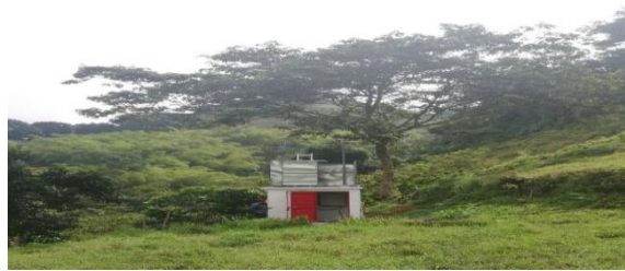
Vista general de la infraestructura de la estación hidrométrica Paso de los Aguadeños, municipio de Circasia.
