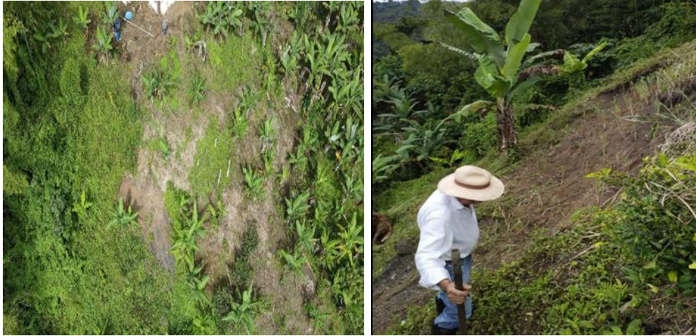
Áreas de fuertes pendientes con problemas erosivos y trabajos de siembra de material vegetal Vetiver y citronela
