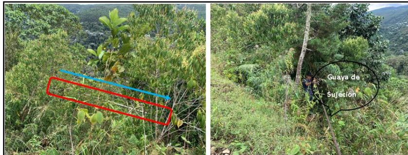
Imagen 3. Afectación punto 1 Coordenadas: 4° 9' 0,82" N -75° 50' 28,30" W. Fuente: CRQ.
