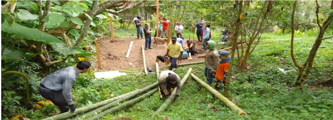
Taller construcción Biofábrica Ecoaldea Illary, Pijao.
