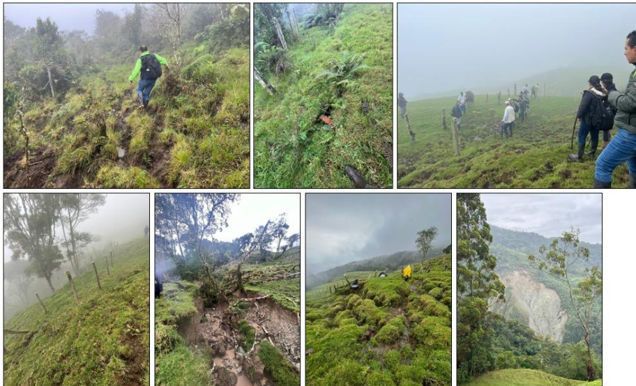
Imagen: Monitoreo afectaciones predio San Luis – Vereda Pizarras -Pijao – febrero 22-2023
