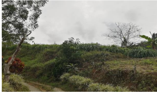
Protección de talud con citronela predio las violetas - Buenavista
