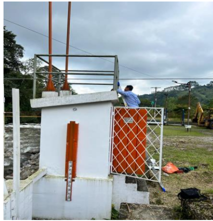
Mantenimiento a la red de estaciones hidrometeorológicas automáticas de la entidad y descarga de datos como respaldo técnico de la información.
