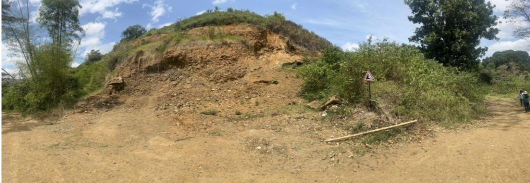
Fotografía 4. Coluvión proyecto minero Contrato de Concesión 22253
