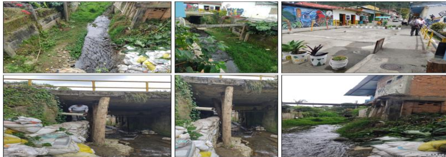
Evidencia fotografías tomadas en el monitoreo Puente calle 11 Quebrada EL INGLES Pijao
