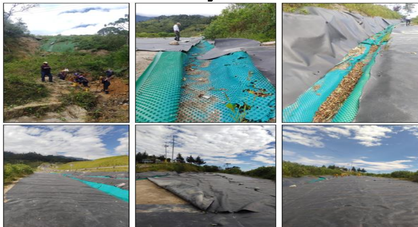
Evidencia fotografías tomadas en el monitoreo sector ZODME municipio de Calarcá
