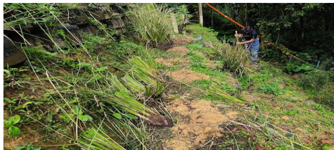
Recuperación de laderas con problemas erosivos.
