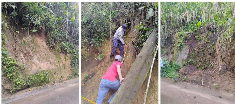
Inspección afectación movimiento de remoción en masa – Quintas del Bosque - Circasia
