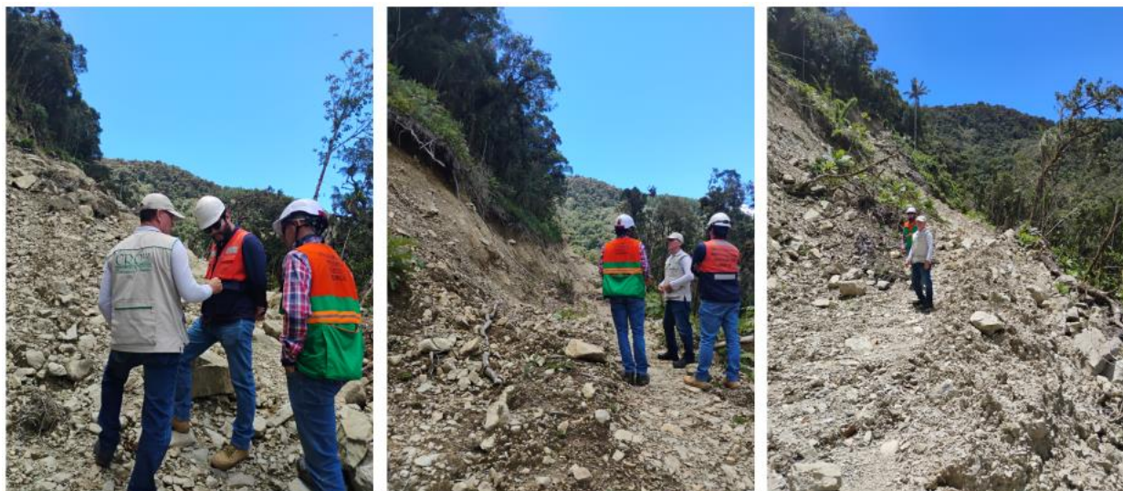
Imagen. Evidencias fotográficas visita realizada Predio Villa Blanca 09/09/2025 - Pijao. Fuente: CRQ
