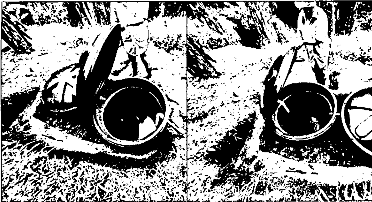
Disposición final (pozo de absorción) - (Sistema 2)
