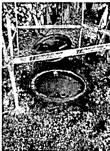
Imagen 4: séptico prefabricado de 1000 litros existente. Fuente: Propia.
