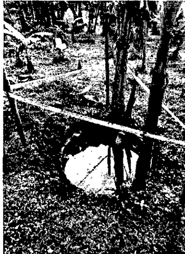
Imagen 5: filtro anaerobio de flujo ascendente prefabricado de 2000 litros existente. Fuente: Propia.
