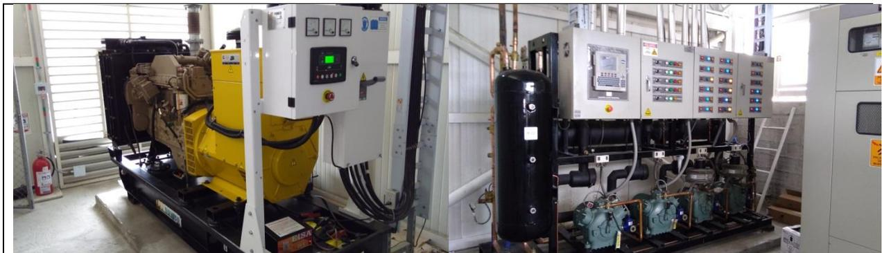
**Foto 1. Planta Eléctrica sin elementos de insonorización**
