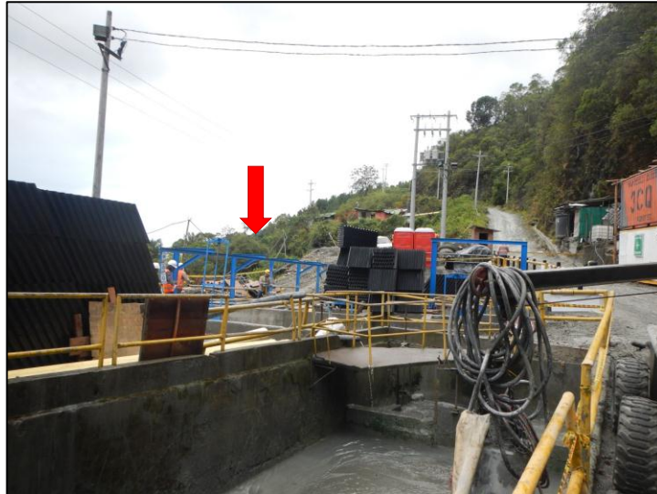
Figura 1. Nuevo tanque sedimentador, Túnel de la Línea
