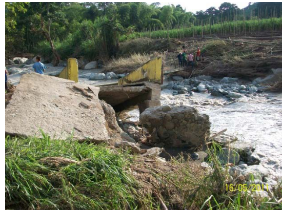
Fotografía 04. Puente sector nisa.
