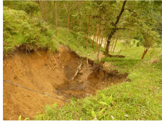
Fotografía 06. Obras de mitigación
