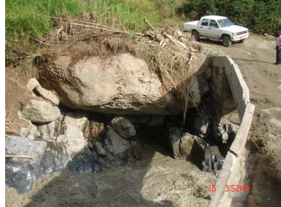
Fotografía 03. Parte alta del puente Guayaquil
