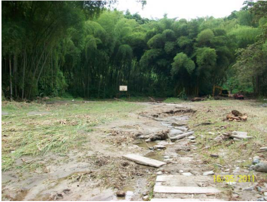
Fotografía 05. Cancha de Baloncesto afectada
