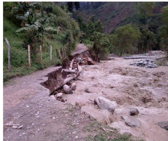
Y en el municipio de Córdoba, se realizó evaluación en la bocatoma los Justos, en donde se pudo observar que debido a los deslizamientos que se presentan en la zona la quebrada los justos se represa producto de esto se ha generado daño en la red de aducción de la estructura de la bocatoma.
