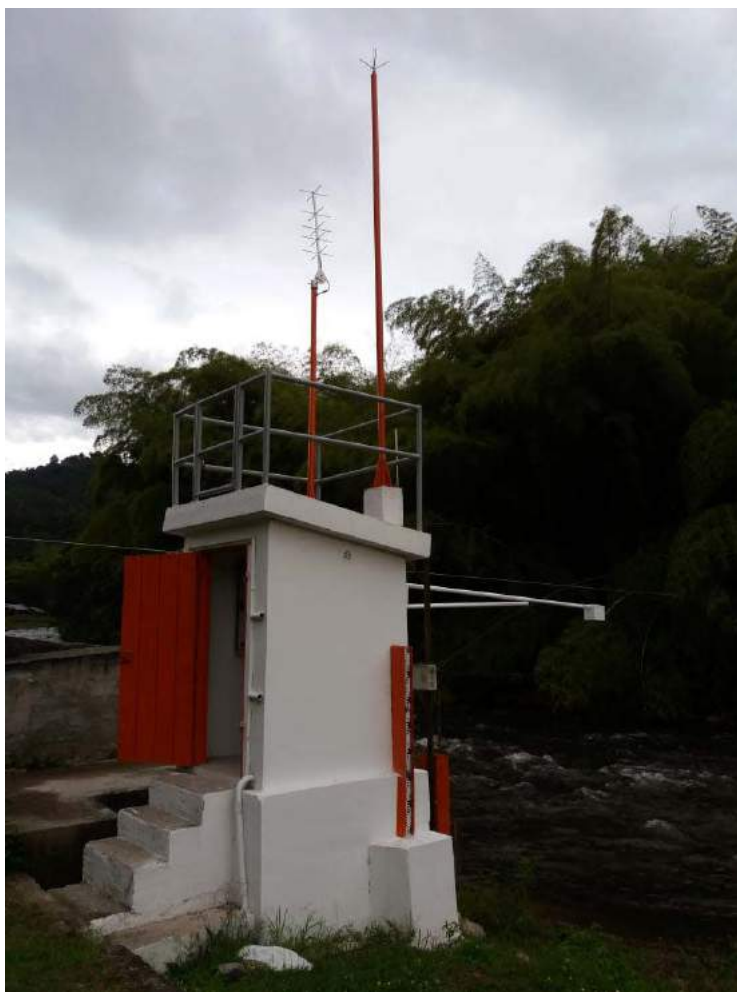
Fotografía 1. Estación hidrométrica automática de nivel Bocatoma EPA.
