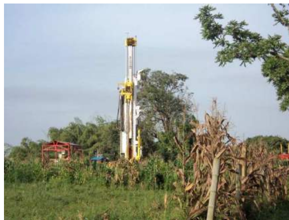
Construcción Pozo profundo – Montenegro
