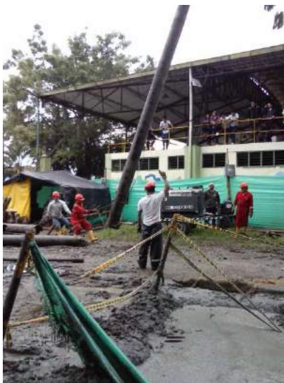
Entubado pozo profundo – Tebaida
