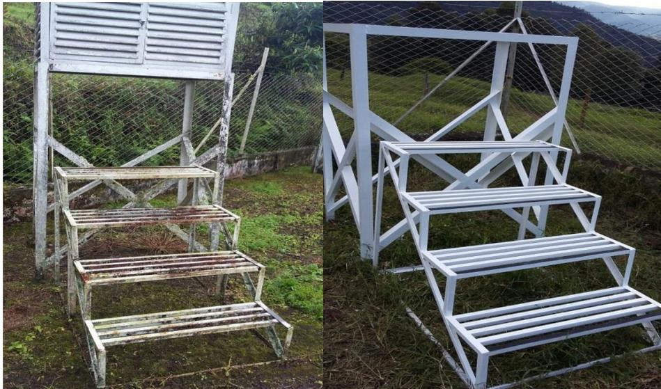
Antes y después del mantenimiento de la estructura metálica de soporte de los abrigos meteorológicos. Estación La Española - El Ocaso, Quimbaya.
