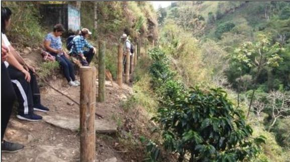
**Foto N° 13.** Vista de la instalación de guaduas para armar los pasamanos
