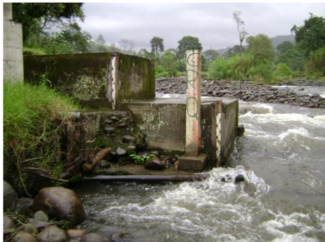
Foto 12 estación limnimetrica Bocatoma EPA
