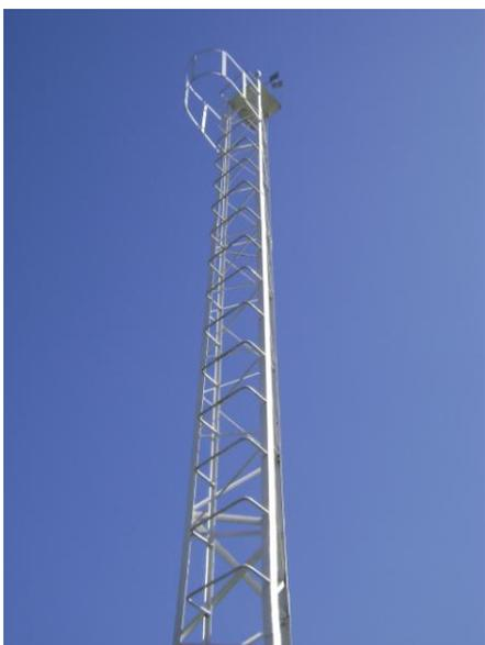
Fig. 6 Mástil de ubicación del anemógrafo
