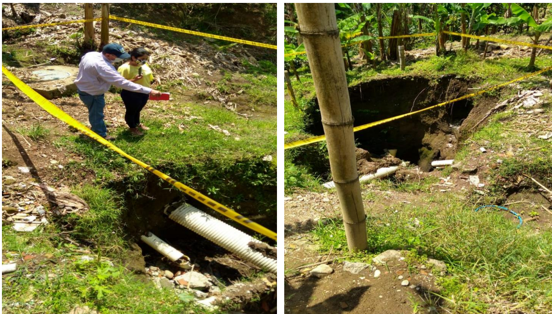
Visita Barrio centenario, municipio de Montenegro, afectación a recamaras de EPQ septiembre 29 de 2020
