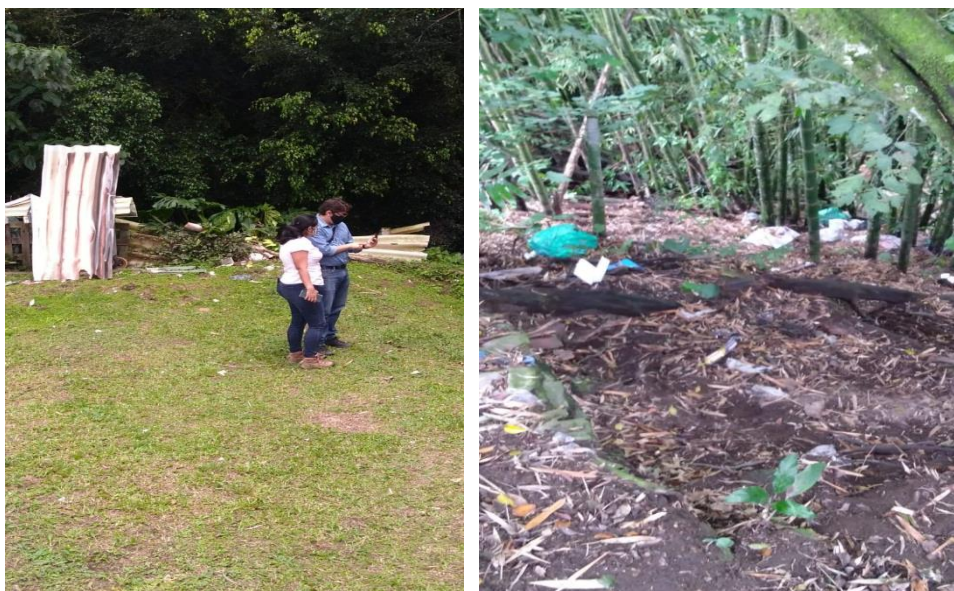
Visita torres de Alcázar, municipio de Armenia. Afectación a fuente hídrica por guadua y residuos sólidos, octubre 05 de 2020
