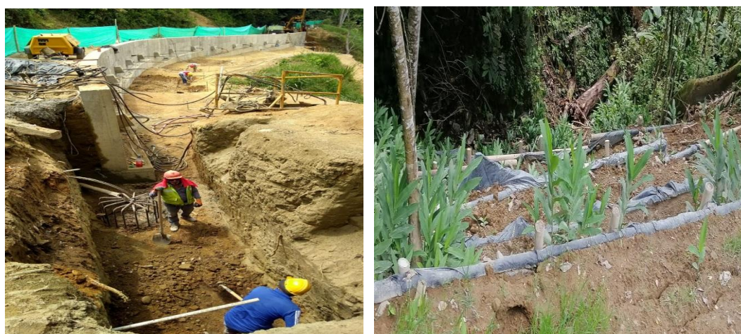
Visitas de seguimiento obras en la vía río verde Pijao y Córdoba vereda carniceros septiembre 28 de 2020
